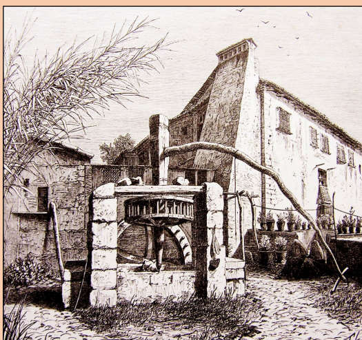
Noria de tiro en el Convento de las Capuchinas (Palma). Grabado de la obra del Archiduque Luis Salvador de Austria. Las Baleares por la palabra y el grabado (1869)
