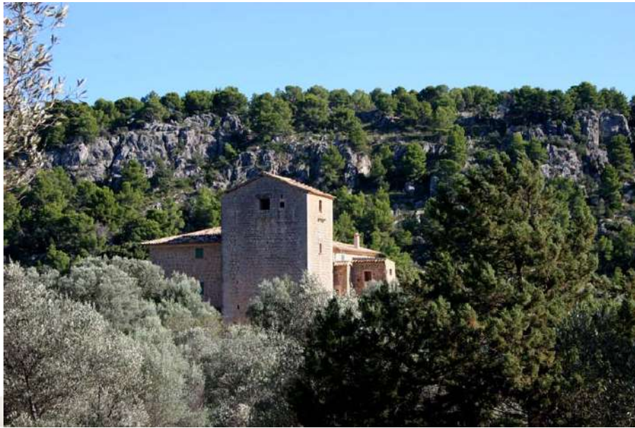
Al vessant costaner de la Serra, moltes possessions compten amb una torre de defensa, la construcció de la qual es remunta a les èpoques de major perill d'atacs per part d'embarcacions turques, en els segles XVI i XVII. A la imatge, la possessió de Muleta Gran, a Sóller.
